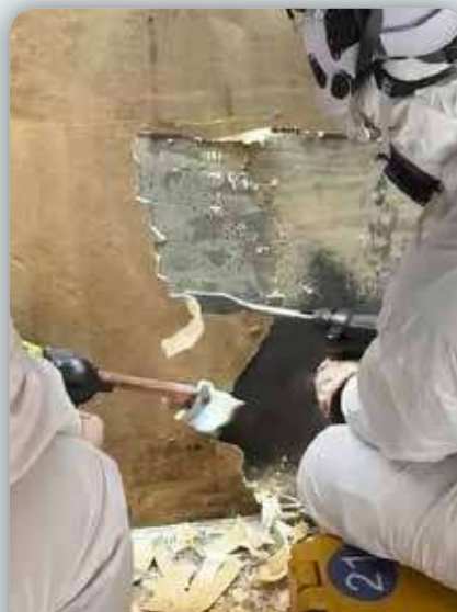
OIL TANK COATING REMOVAL - DÉCAPAGE DU REVÊTEMENT D'UN RÉSERVOIR Inductor L20 Alu Glove Powerduction 220LG
